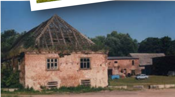
Das Brau- und Brennhaus mit Domänenhof vor der Sanierung
